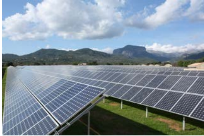
Foto: Planta solar ubicada en la isla de Mallorca. Operación, Mantenimiento y Gestión a cargo de Optimal Sun, partner oficial de Alectris en España.
