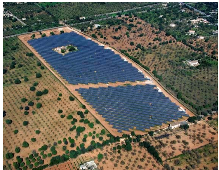
Foto: Planta Solar Fotovoltaica de 3,1 MW, fija en suelo, ubicada en la isla de Mallorca, gestionada por Optimal Sun, partner oficial de Alectris en España.
