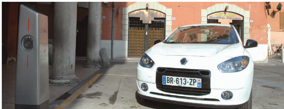
UNA STAZIONE DI RICARICA INSTALLATA DAL COMUNE DI MODENA IN PIAZZA ROMA. MOLTE AMMINISTRAZIONI LOCALI HANNO INSTALLATO COLONNINE E PREVISTO AGEVOLAZIONI PER L'ACQUISTO DI MEZZI ELETTRICI
