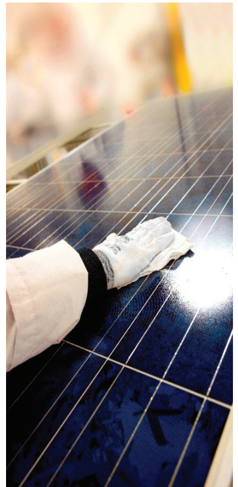
LA PULIZIA È UN'ATTIVITÀ DI MANUTENZIONE FONDAMENTALE, CHE CONSENTE DI MANTENERE ALTO IL RENDIMENTO DELL'IMPIANTO
